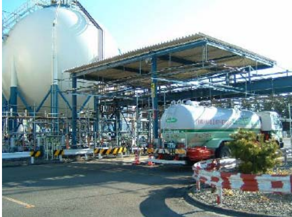
①工事前の積み場
